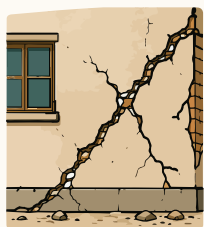
rachaduras estruturais graves,
